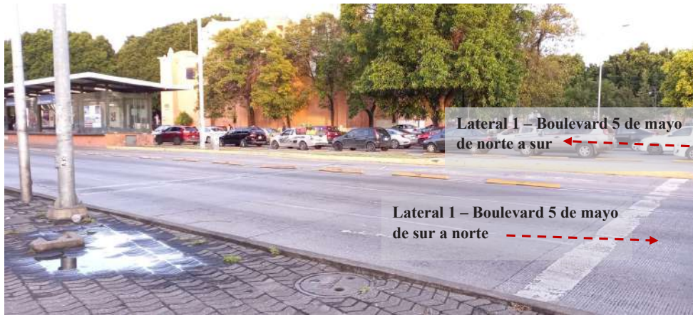
Figura 13. Estación de San Francisco, tramos a evaluar en ambas laterales del Boulevard 5 de mayo.
