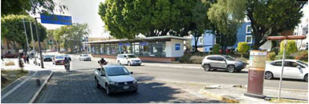
Figura 17. Vulnerabilidad del peatón por el flujo vehicular en la zona de Analco Fuente: Street View de Google Earth Pro, 2022.
