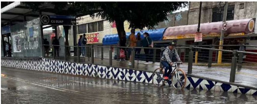
Figuras 7 y 8. Inundaciones y falta de accesibilidad a las estaciones del Sistema RUTA. Fuente: Alvarado, 2022 y Guevara, 2022
